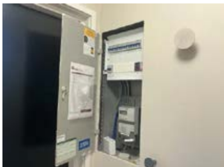
Sikringsskap står i entre/gang.
