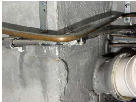
Kobberrør på badetrom
