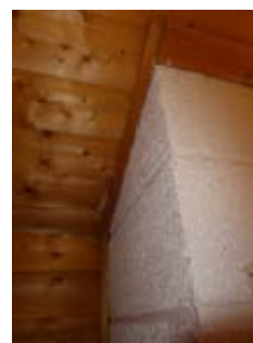
Pipegjennomføring i tak kontrollert
