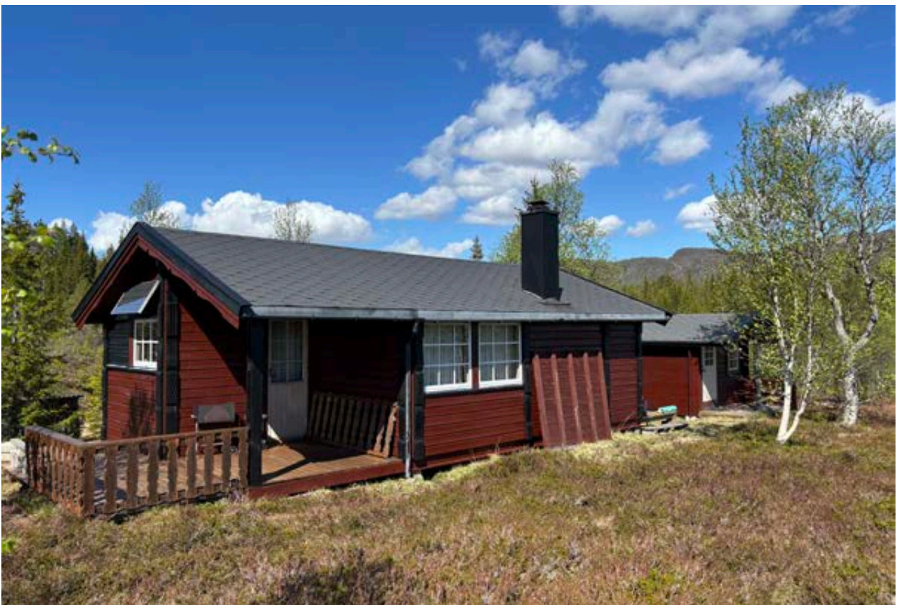
Hytten med delvis overbygget terrassedel med adkomst fra soverommet
