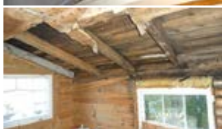
Rom mot sørøst 2.etg. Råte og "blåved" i taktro.
