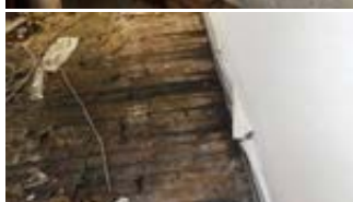
Råteskade på gulv i 3.etg. rom nordvest.
