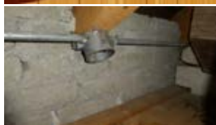
Raftekott. Viser murverk i yttervegg
