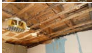
Pensjonat 2.etg. mot nordvest
