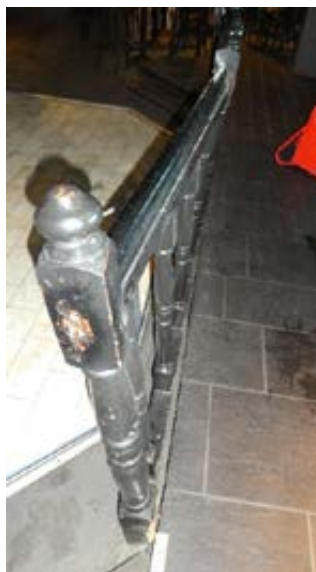
Defekt rekkverk ved dansegulv
