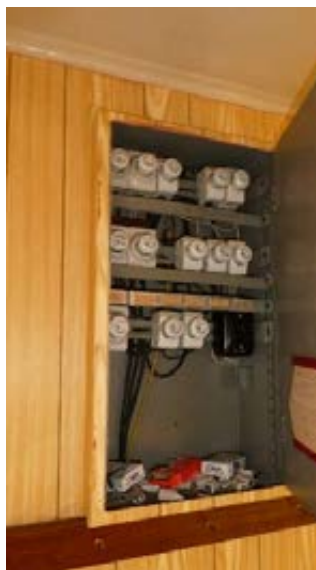
Elskap. Fordeling med skrusikringer.
