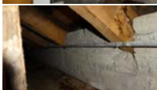
Raftekott. Viser murverk i yttervegg
