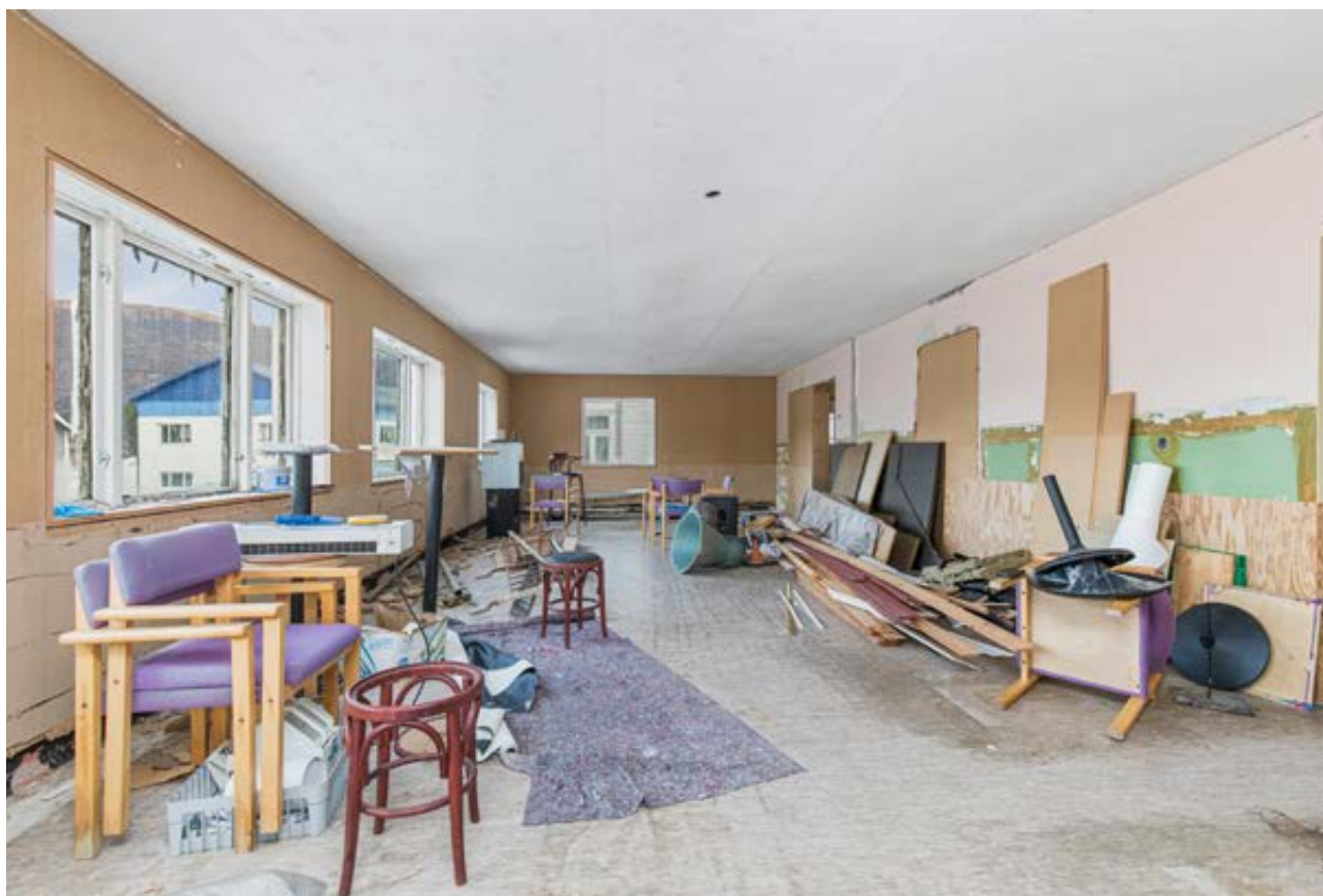
Bygget mot vest står innfor totalrenovering
