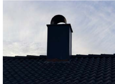
Skorstein over tak.
