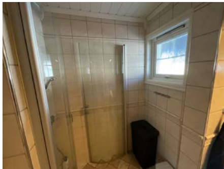
Vindu i våtzone.
