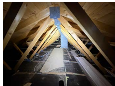
Oversiktsbilde av kaldloft.
