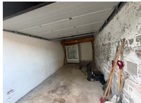
Oversiktsbilde av garasje.
