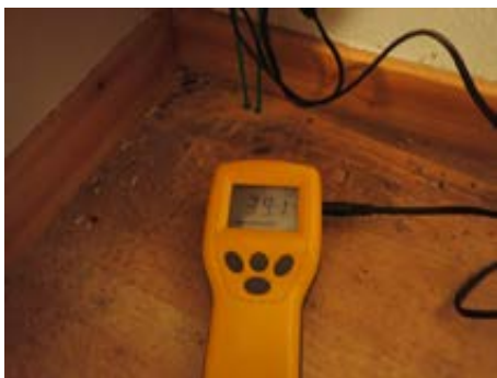
Fuktmåling i betonggulv.
