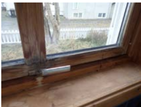
Råteskadet vindu
