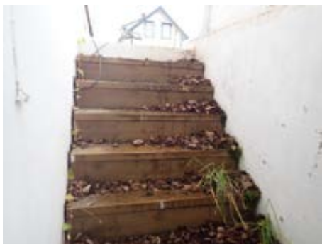
Kjellertrapp mangler håndlist - begge sider.
