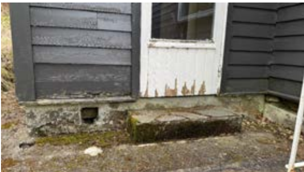
Ved utgang bakgang. Kryp kjeller uten tilgang (ventil)
