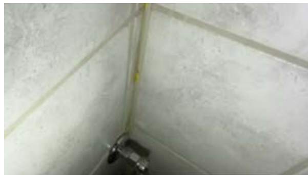
Maskeringstape under fuge i ett hjørne.
