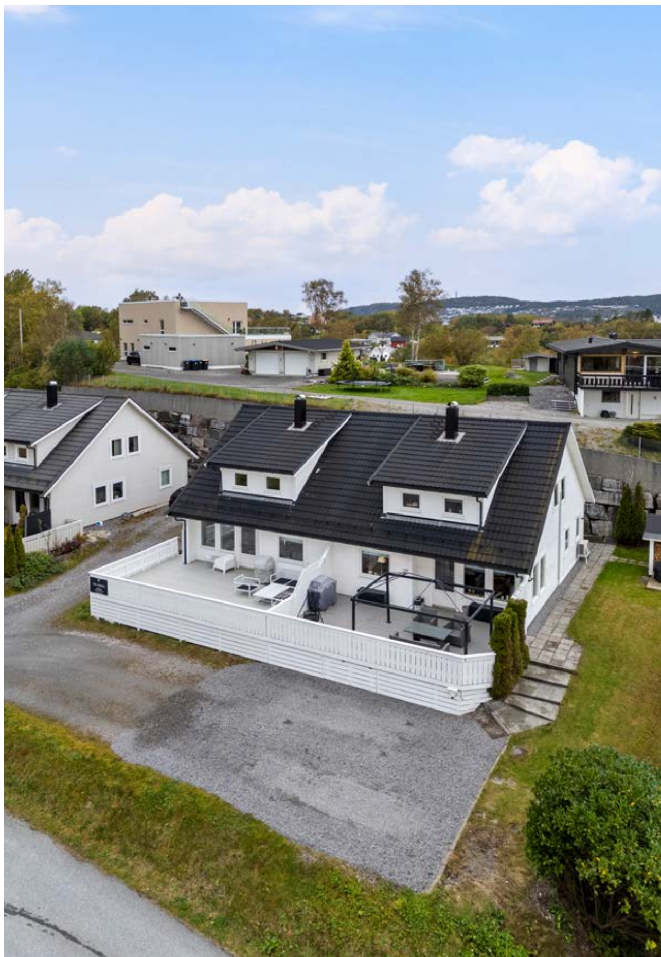
Terrassen/verandaen fremkommer ikke på byggemeldte tegninger
