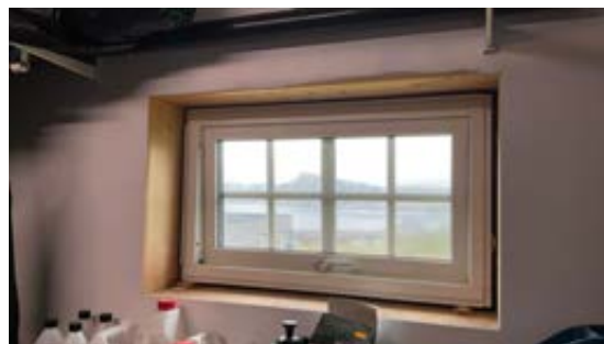
Gjenstår sluttmontering vindu
