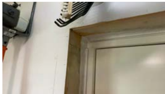
Gjenstår sluttmontering dør
