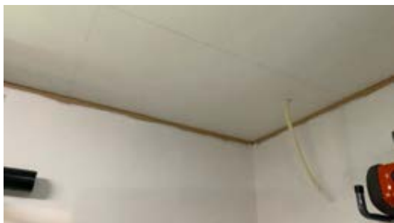
Gjenstår sluttmontering listverk
