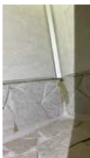
Fugeslipp mellom bunnprofil og veggplate idusjnisje
