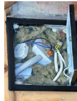
Luke over kjøkkenbenk med div. elektrisk. (
