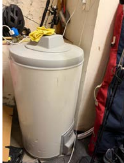
Bereder i kjellerbod med Waterguard/vannsikring
