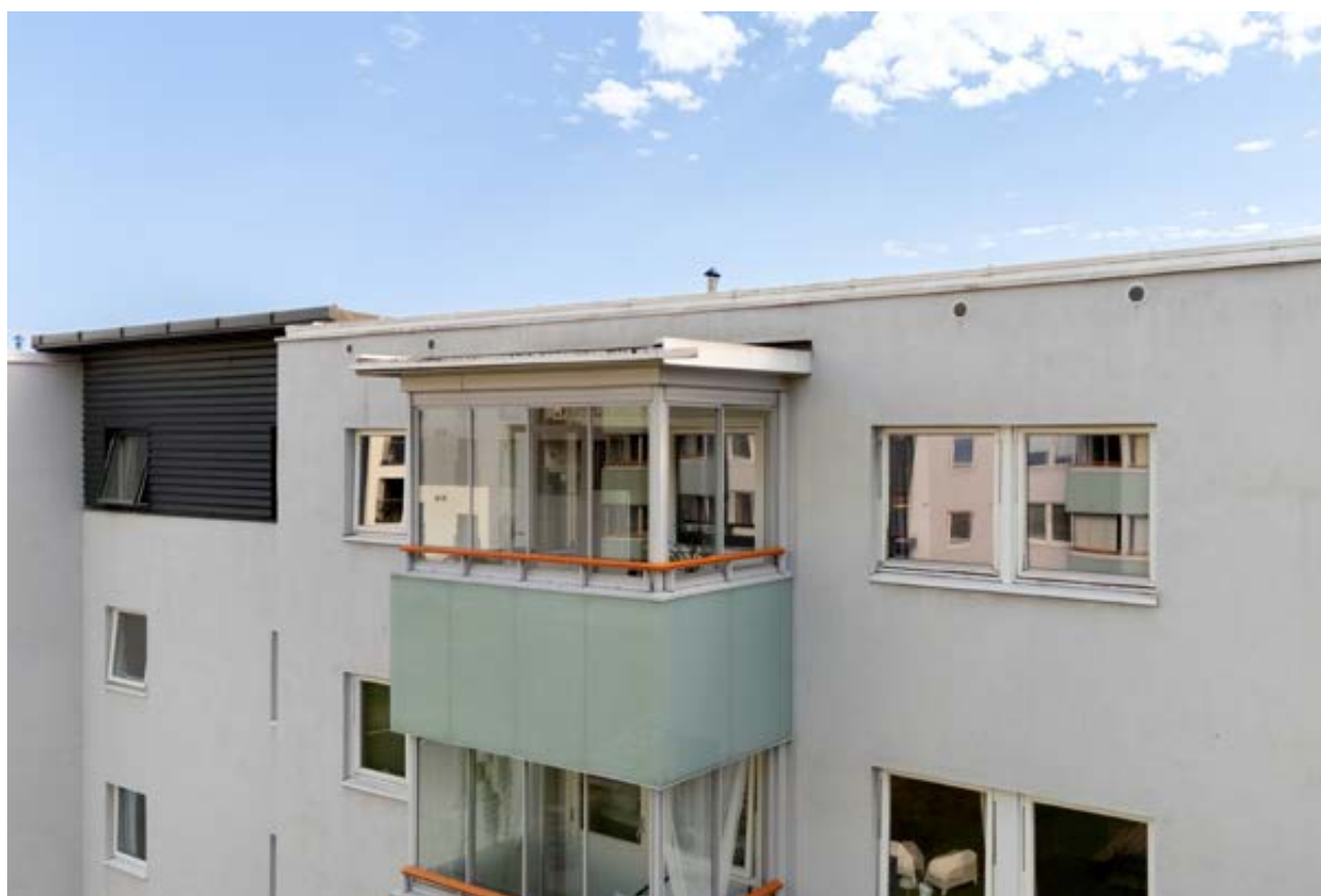
Toppleilighet med innglasset balkong.
