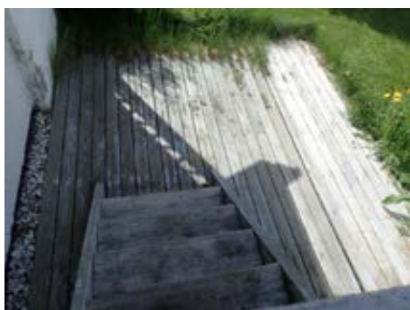
Trapp fra terrasse dekke til altan
