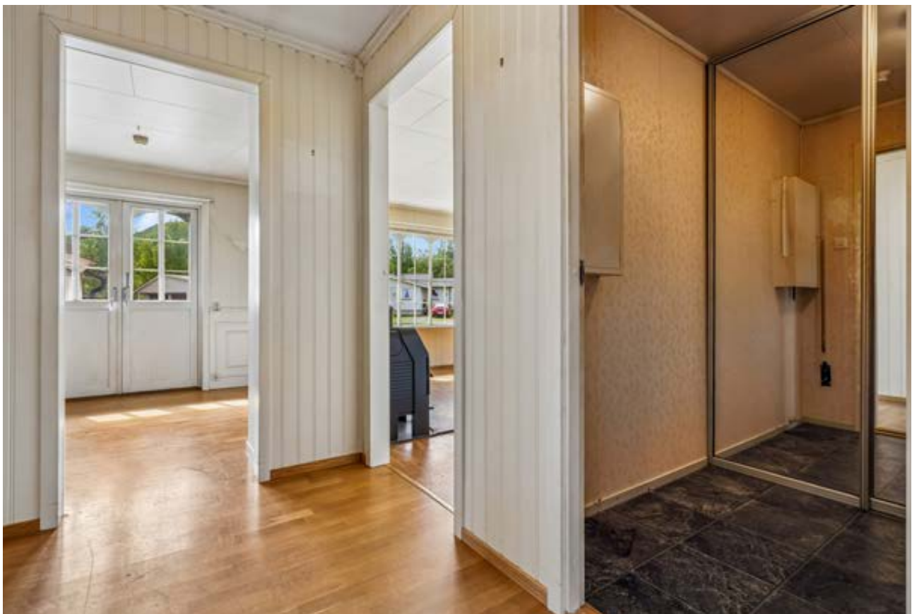
Entré m/garderoberom som har skyvedørs garderobe- sikringsskap m/automatsikringer på vegg
