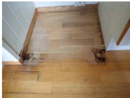
Fuktskader i gulv ved kjøleskap
