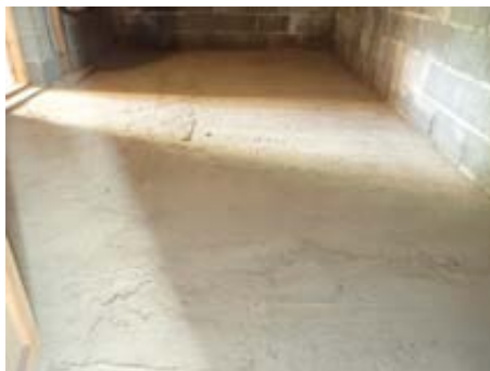
Grovstøpt betonggulv
