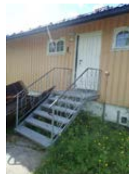
Strekkmalltrapp foran hovedinngang
