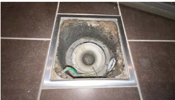
Kontroll av sluk.
