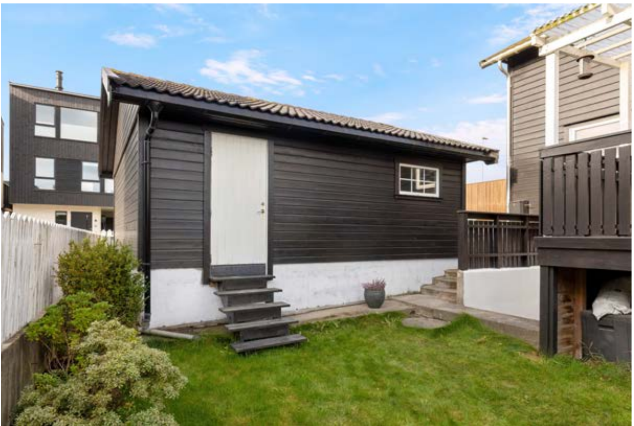
Fasaden har en praktisk utvendig trapp i tre og en velholdt hage som gir et innbydende førsteinntrykk.
