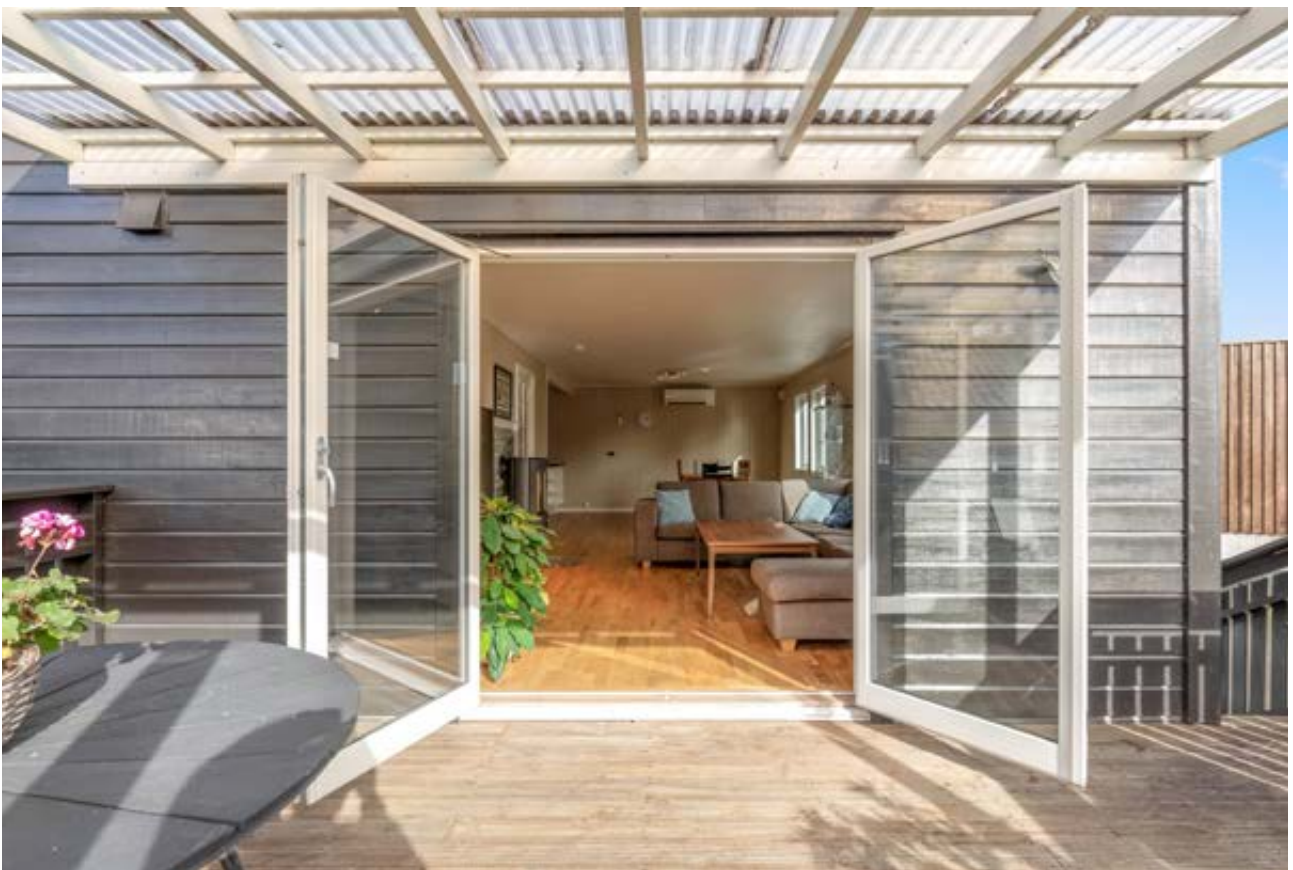
Terrassen har et overbygg av bølgeplastplater, som gir ly for vær og vind mens man nyter uteplassen.
