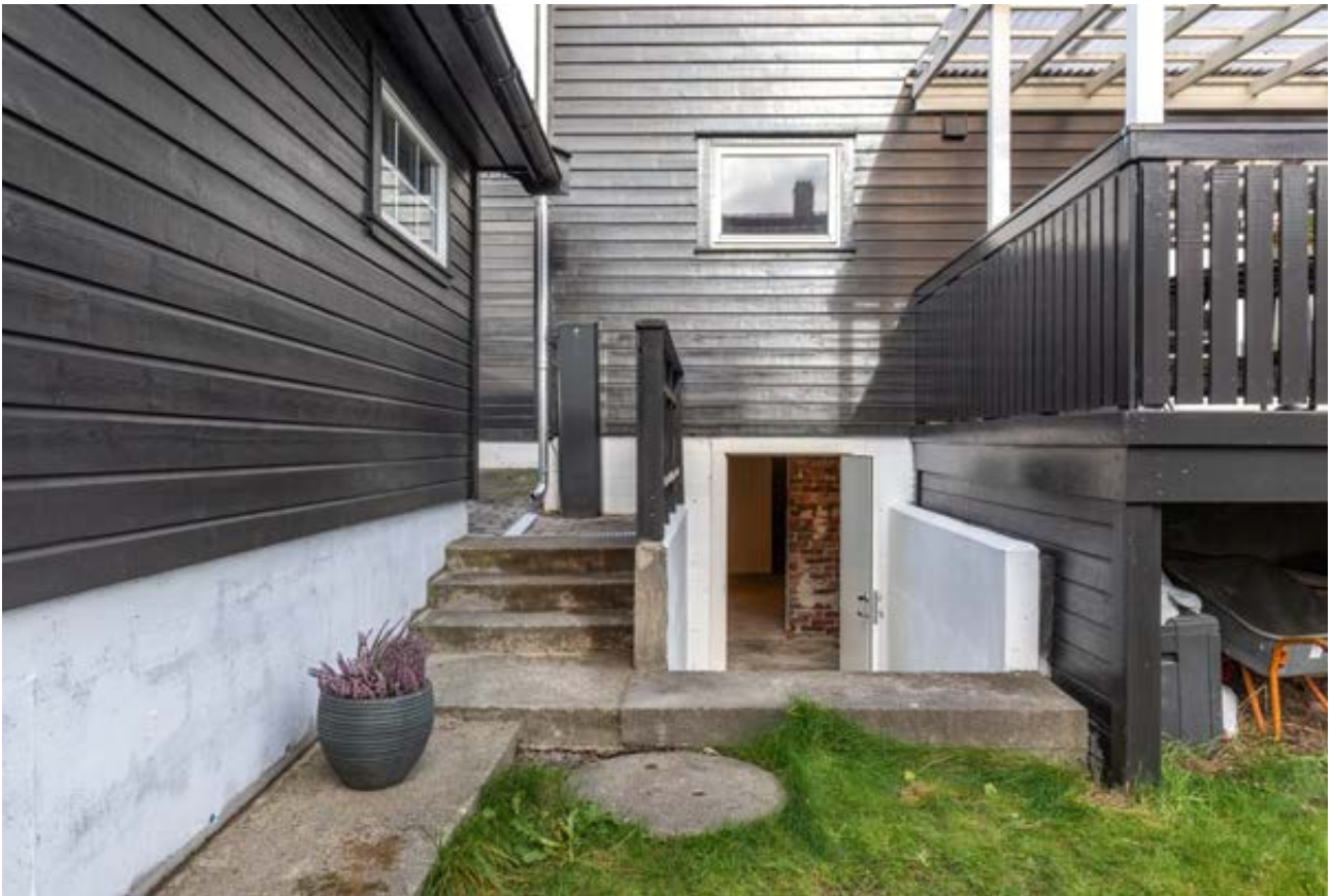
Utvendig adkomst til kjeller via en trapp i betong, med direkte inngang til kjellerstue.
