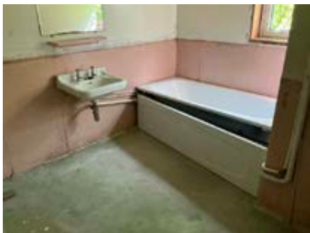
Bad i kjeller
