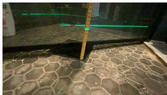
Høydeforskjell (ved sluk)
