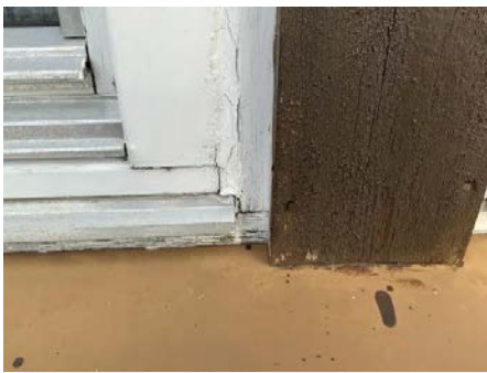
Vindu i 2 etasje fremstår som vær-slitt.
