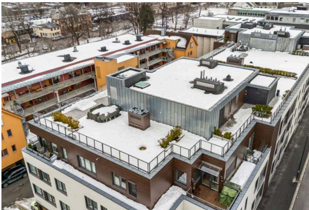
Felles takterrasse med god plass til hygge.
