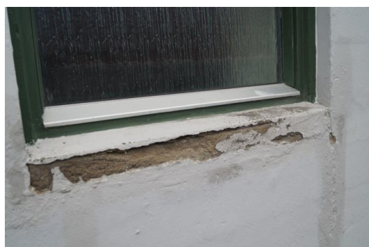
fuktskade i utvendig karm på stuevindu mot vest
