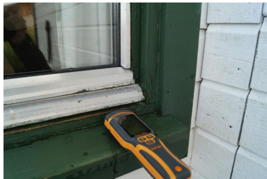
fuktskade i utvendig karm på stuevindu mot vest
