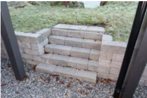
Forstøtningsmur/trapp av betongstein.
