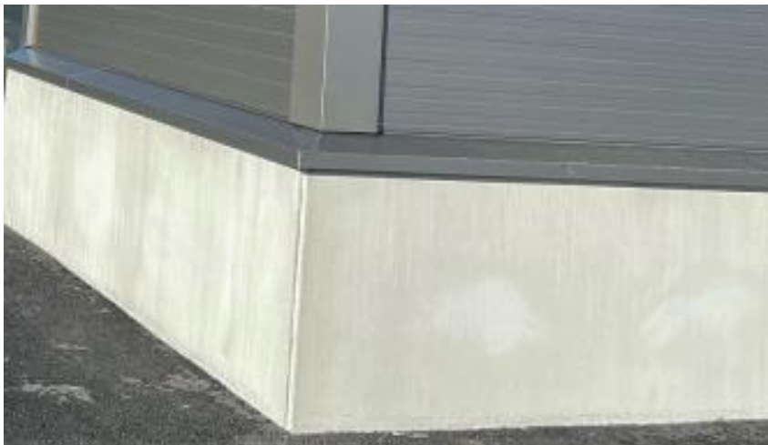
Figur 2 Illustrasjon av isolert betongbrystning/ringmur
