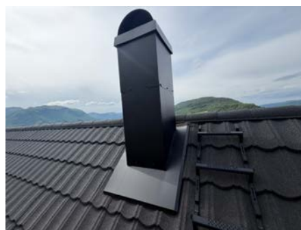
Skorstein over tak.
