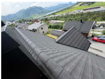
Oversiktsbilde av taktekking, ingen avvik påvist.
