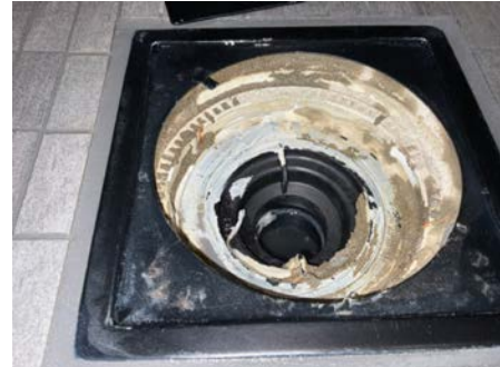
Sluk. Spor etter membran klemt under klemring.
