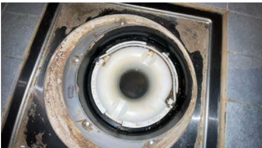
Sluk i dusjsonen
