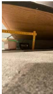
Høydeforskjell (ved sluk under servant)
