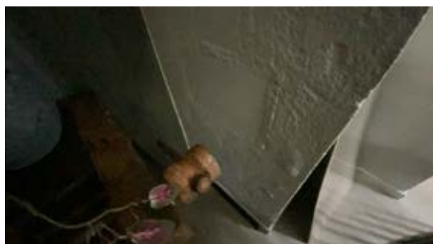
Sotluke i entre.
