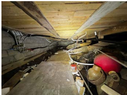
Det er målt 19,3 vektprosent i stubbegulvet.
