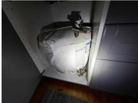
Varmtvannstank.
