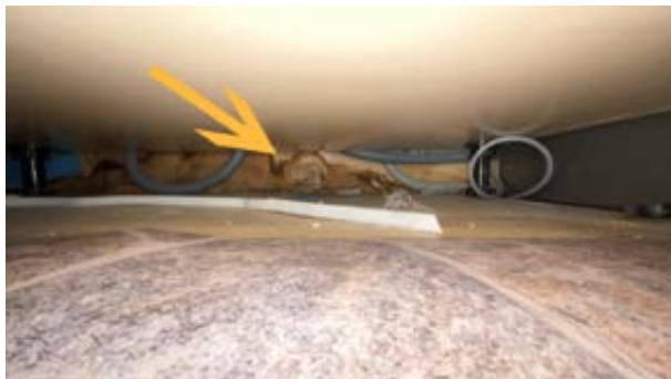
Fuktskjolder i vegg bak kjøkkenet
