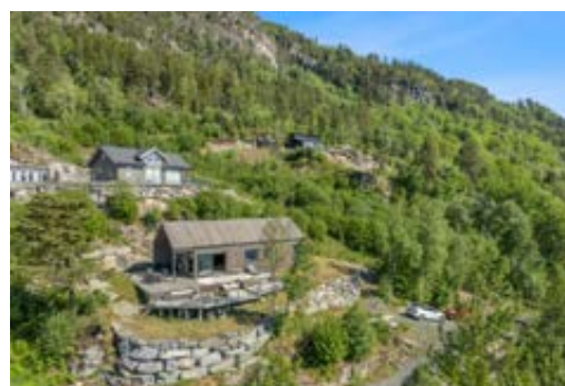
Bildet viser at hytta er bygd på fylt terreng med natursteinsmurer i front
