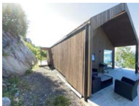
Oversikt overside og gavelvegg ved terrasse som har takoverbygg
