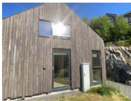
Vindu på soverom og hems med godkjent rømningsvindu
