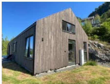
Gjenstående kapping av kledning på gavelvegg
