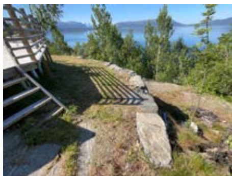
Bilde er tatt på siden av veranda
