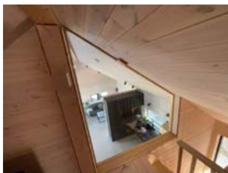
Gjenstår liste inn vindu mot stue. Vindu er sikret med klosser
