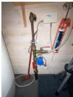
Hovedstoppekrane og vannstopventil på teknisk rom/toalett
