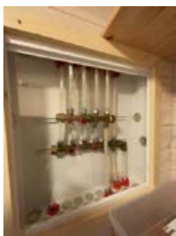
Hovedstoppekrane og vannstopventil på teknisk rom/toalett
