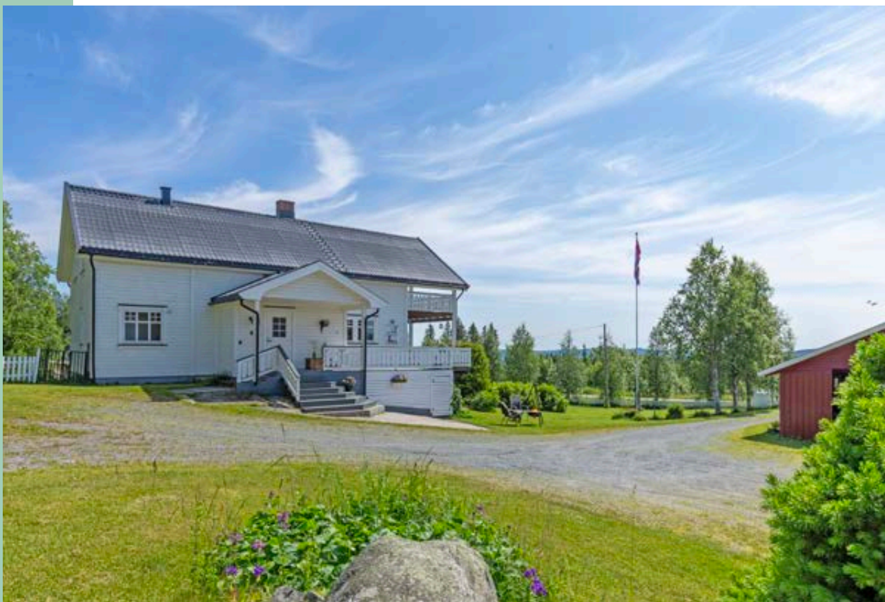
Våningshus over to etasjer og med innredet kjeller
