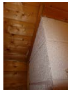
Pipegjennomføring i tak kontrollert
