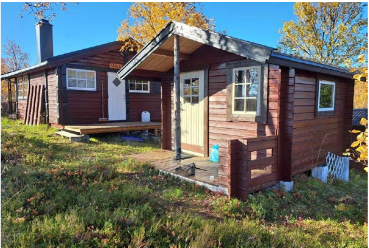
Nye uthuset i front og hytten
