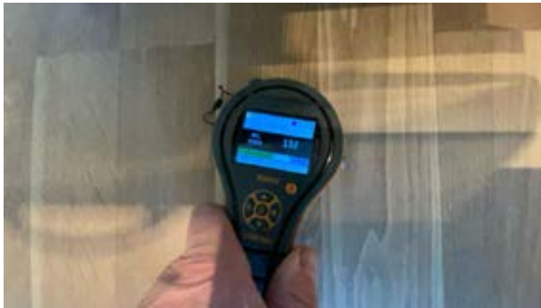
Ingen unormale verdier på gulv nedenfor vask/oppvaskmaskin.
