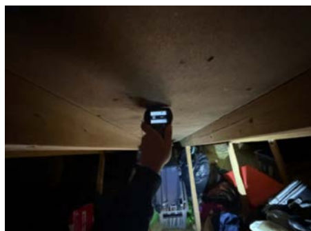
Fuktmåling i undertak, ikke utslag på fukt.
