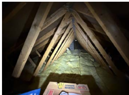
Oversiktsbilde av kaldloft, store deler av loftet er etterisolert.
