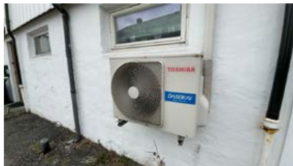
Uteenhhet for luft til luft varmepumpe.
