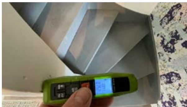
Lysåpning i trapp.
