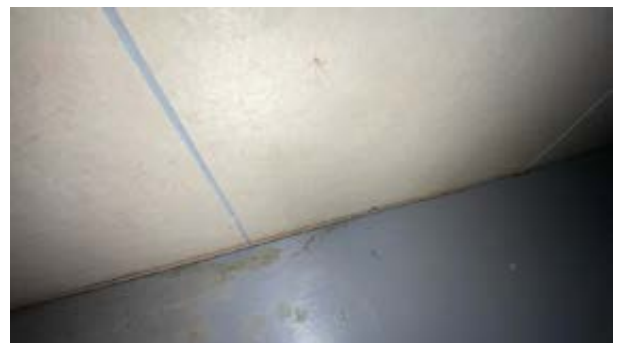
Manglende fuger mellom benkeplate og vegg.
