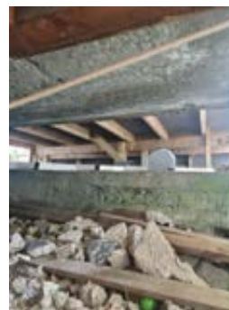
Bjelkelag i fremre del av terrasse.
