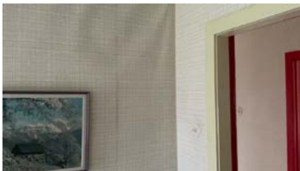
Pipe på loft skjult av strekt papp som er tapetsert
