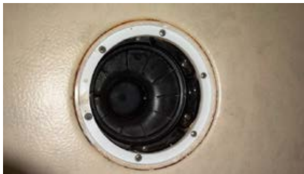
Sluk bad/vaskerom i 1. etasje
