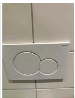
Fuge løsnet mellom flis
