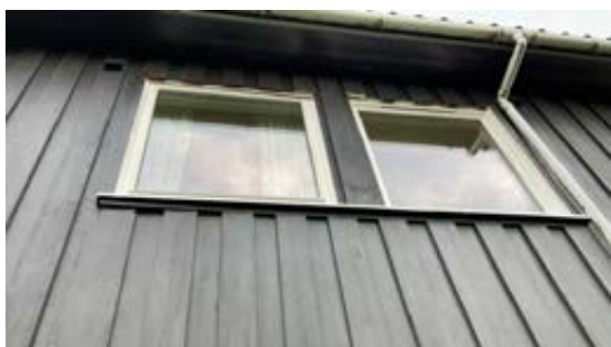
Vinduer uten beslag over.
