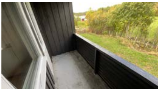
Veranda mot nord ved soverom.
