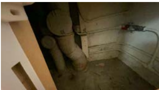
Avløpsrør med stakemulighet.
