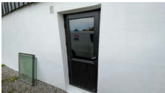
Dør fra vaskerom. tilhørende hovedenhet.
