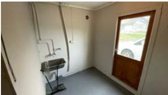
Vaskerom til hovedenhet i sokkeletasje med egen utgang.
