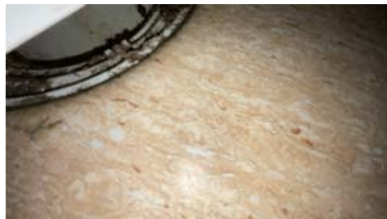
Sluk under dusjkabinett.
