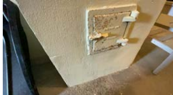
Sotluke i sokkeletasje med tilgang fra hovedenhet.
