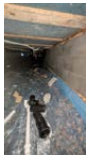
Oversiktsbilde av krypkjeller og avslutning av plast.
