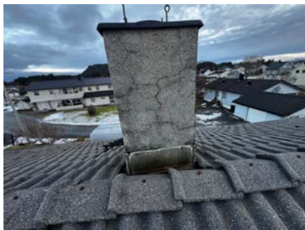
Oversiktsbilde av skorstein over tak.
