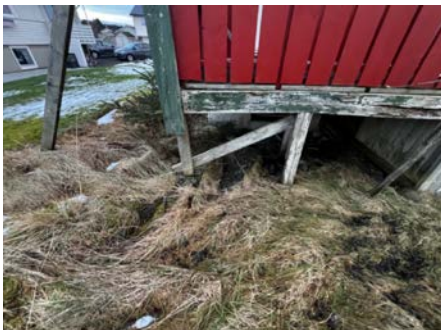
Fundamentering til veranda med utgang fra soverom.
