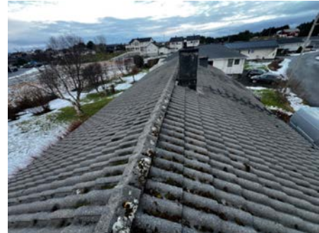
Oversiktsbilde av taktekkning.
