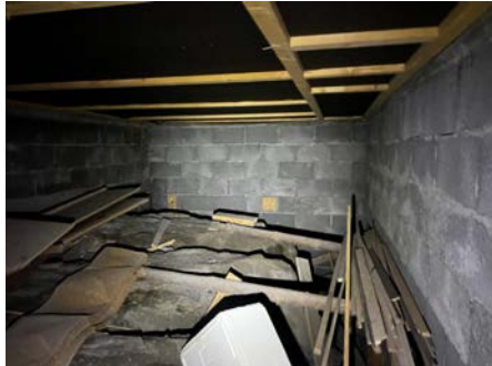
Oversiktsbilde av krypkjeller.
