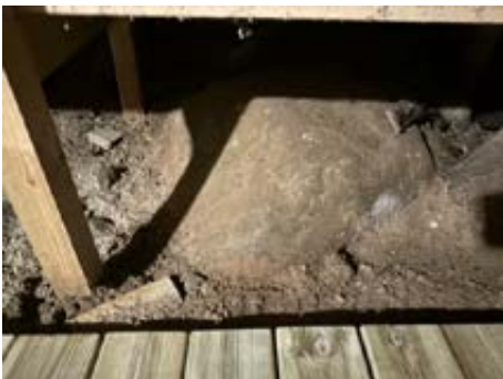
Jordgolv med terrassebord.
