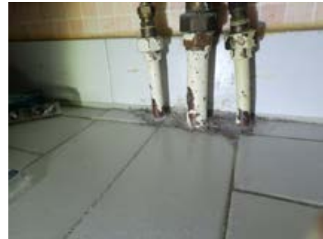
Utett rørgjennomføring
