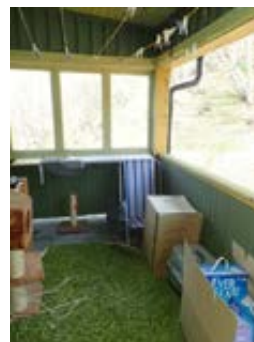
Overbygget altan/terrasse i 2.etg
