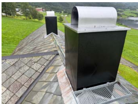
Oversiktsbilde av taktekkning.
