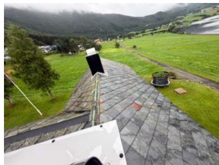
Oversiktsbilde av taktekkning.
