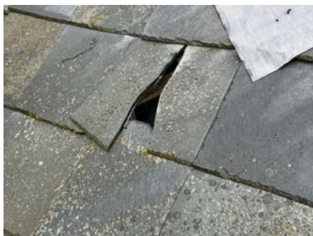
Oversiktsbilde av taktekkning.
