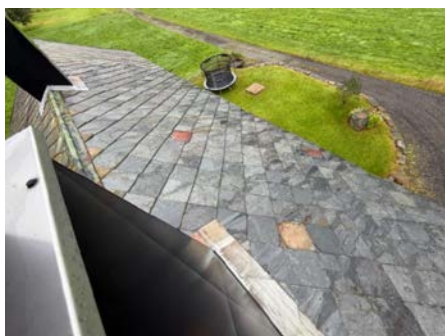
Oversiktsbilde av taktekkning.
