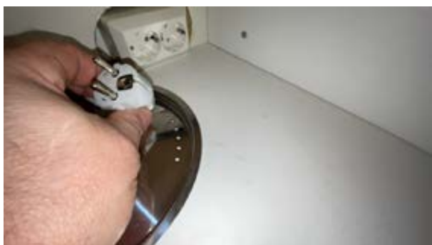
Ingen svimerker på stikk ved dagens befaring.
