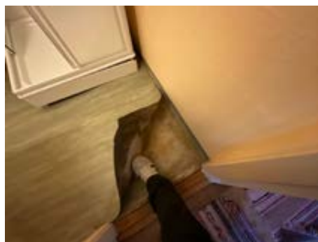
Løst gulvbelegg uten oppkanter.
