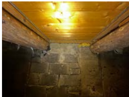
Oversiktsbilde av etasjeskiller mellom kjeller og 1. etasje.
