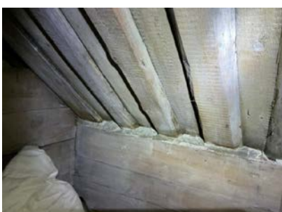
Synlig undertak fra byggeår på kott. Eventuell lufting i konstruksjon er ikke tilgjengelig for kontroll.
