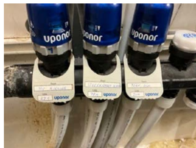
Lekkasje fra kobling i rør i rør skap.
