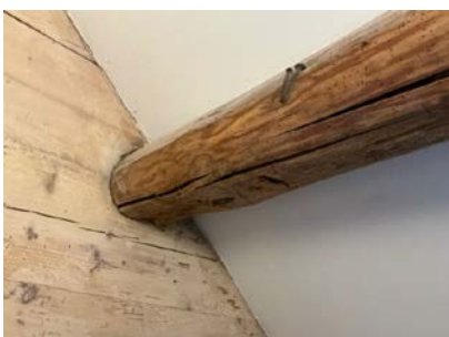
Synlig tømmervegger fra byggeår på noen vegger.
