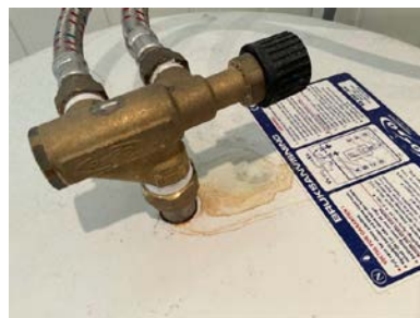
Flekker som minner om fuktskjolde.
