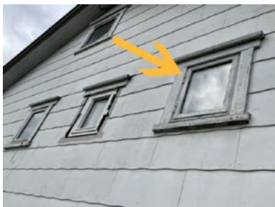
Dette vinduet er ikke synlig fra innsiden.
