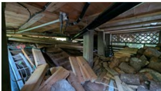
Bjelkelag sett fra undersiden.
