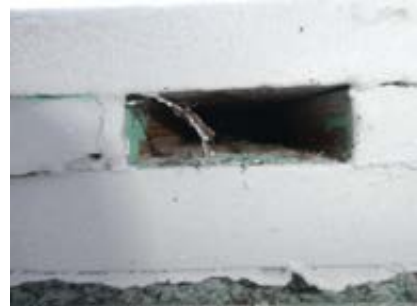
Musesperre må monteres på hulrom bak kledning
