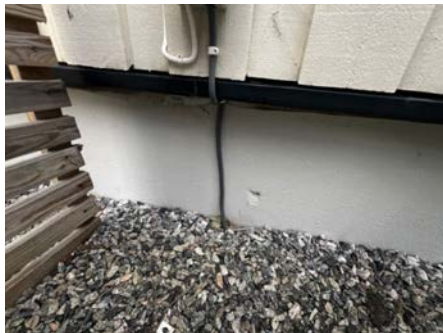
Strømkabel til jacuzzi som mangler beskyttelse.
