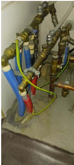
Bilde 1 Ledninger er festet og påmontert enedehylser etter at bilde er tatt.
