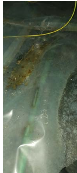
Bilde 2 Tilførselskabel er ikke festet.
