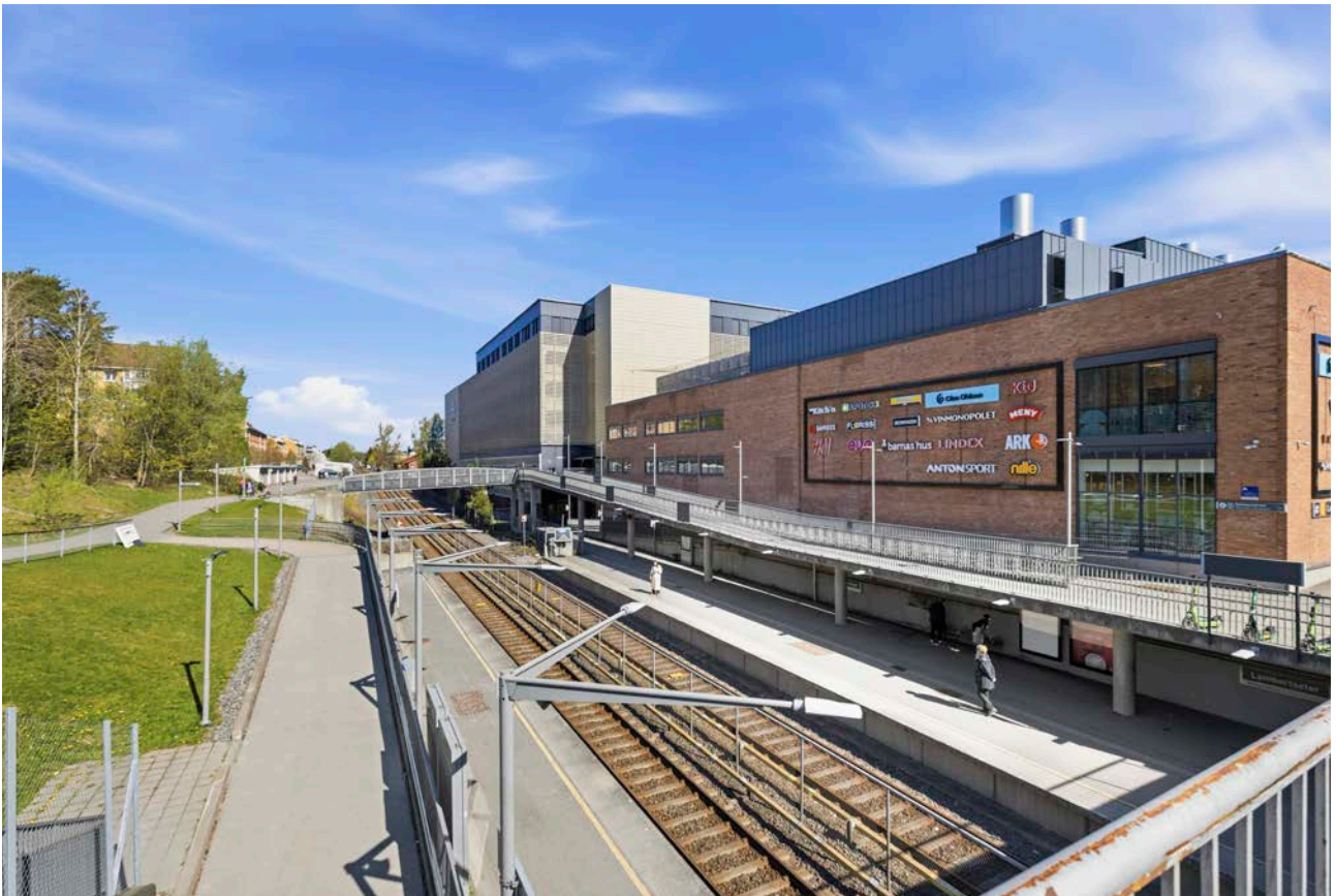
Kollektivtilbudet er svært godt, med kort gangavstand til Lambertseter T-banestasjon som tar deg til Oslo sentrum på ca. 20 minutter.
