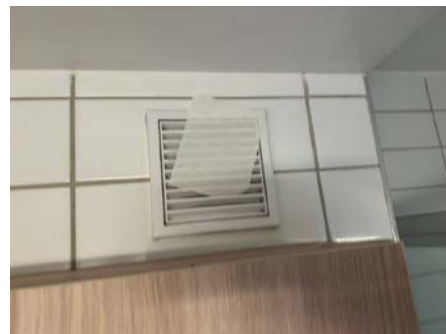
Test av avtrekk. Papiet henger.
